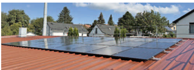
Photovoltaikanlage Feuerwehrgerätehaus Hattenweiler
