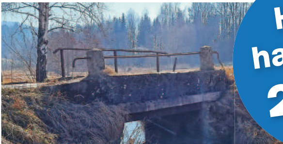
Erneuerung Brücke Unterboshasel-Halden
