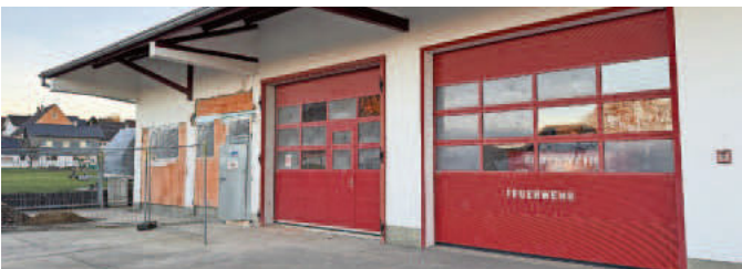
Umbau Feuerwehrhaus Hattenweiler
